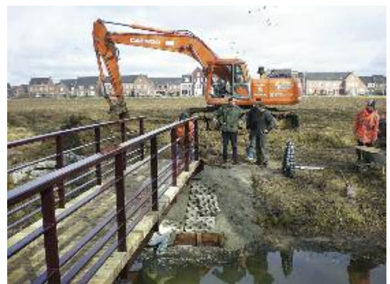
Figuur 6: Plaatsing van de eerste brug in parkstijl in deelgebied De Park (één van de quick-wins)
